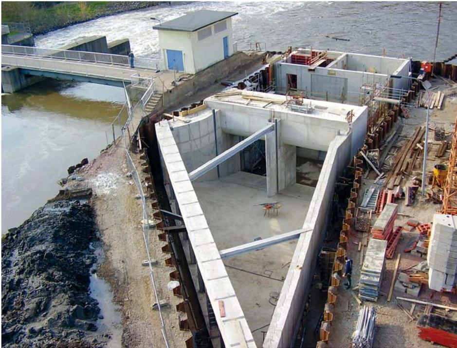
Abb. 3: Die als Buchtenkraftwerk konzipierte WKA Halle-Planena wurde rechtsseitig der Staustufe im Gewässervorland errichtet.
