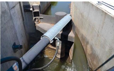
Abb. 14: Schachtartige Bypässe mit selbstreinigenden Regelorganen ermöglichen bei geringem Unterhaltungsaufwand einen dauerhaft funktions-sicheren Betrieb. Oben: Bypass im Bau (Blick zum Unterwasser), unten: Eintrittsbereich eines Bypasses mit selbstreinigender Klappe im Betrieb (Blick zum Oberwasser). Fotos: G. Ebel
