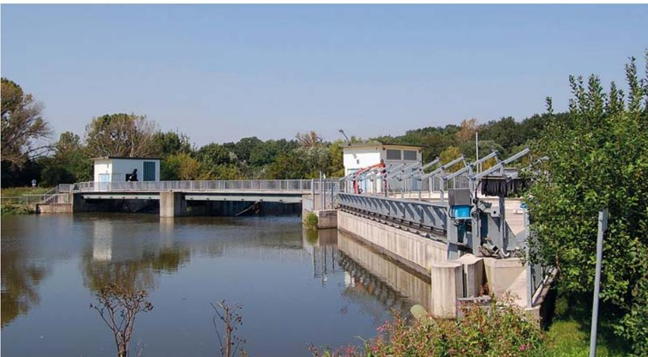
Abb. 1: Pilot-Wasserkraftanlage Halle-Planena mit Leitrechen-Bypass-System nach Ebel, Gluch & Kehl
